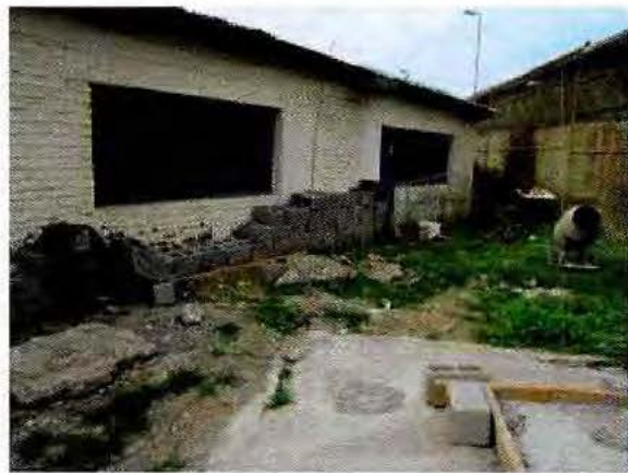
Fotografía N°3: Elementos de construcción en patio trasero de casa N°2.
