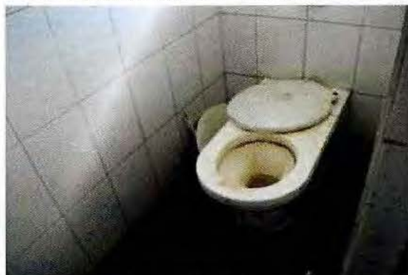
Fotografía N°10: Artefacto sanitario con deficiencia de aseo y en mal estado, CIP-CRC Santiago, 31 de marzo de 2015.
