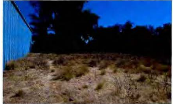
Fotografía N°16: Deficiente mantención de áreas verdes, es especial poda de árboles y control de malezas que representan riesgo de incendio.
