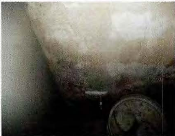
Fotografía N°3: Dormitorio con humedad y moho en pared colindante con duchas de baño, Centro Metropolitano Norte Til-Til, 26 de marzo de 2015.
