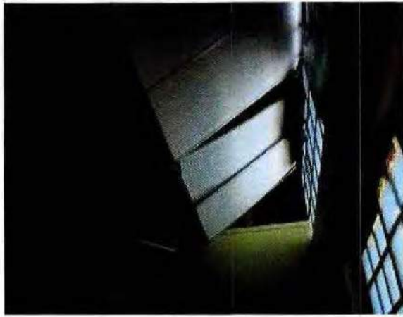
Fotografía N°1: Palmetas de cielo sueltas en sala de clases de colegio.
