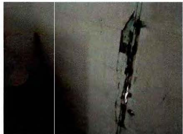
Fotografía N°14: Cerámicos desprendidos en baño casa N°2.
