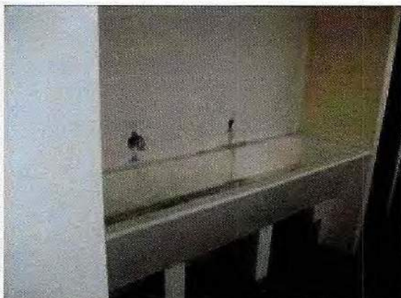
Fotografía N°11: Ausencia de griferías de lavamanos en baño de casa N°7 no utilizada, Centro Metropolitano Norte Til-Til, 23 de marzo de 2015.
