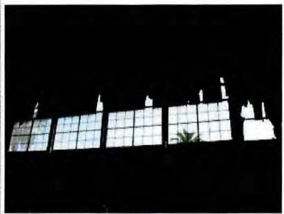
Fotografía N°20: Daño en revestimiento de gimnasio, CIP-CRC Santiago, 31 de marzo de 2015.
