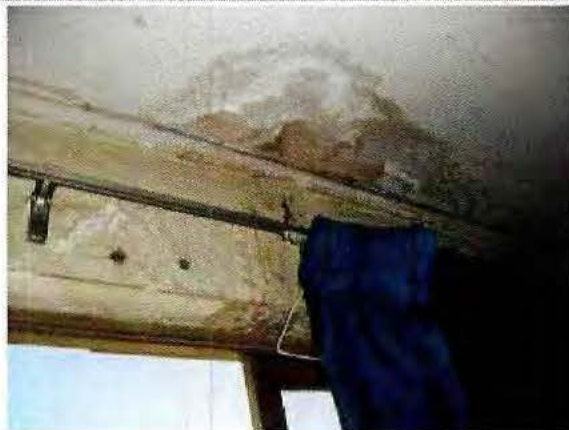
Fotografía N°3: Dormitorio con humedad y moho en pared colindante con duchas de baño, Centro Metropolitano Norte Til-Til, 26 de marzo de 2015.
